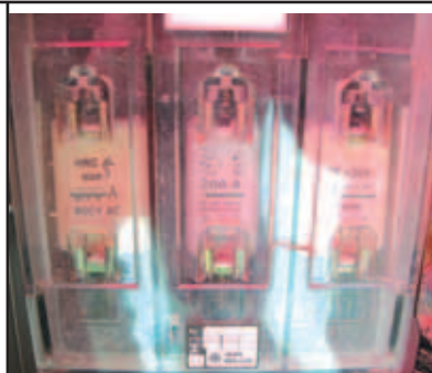
الشكل (١٣-٦) : مصهرات خرطوشية ومصهرات سكنينية بسعة ٢٠٠ أمبير (محمية بعازل بلاستيكي) سريعة الفصل ضد تيار القصر
