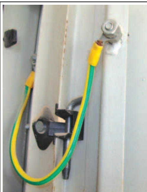
الشكل (١٣-٨) : تثبيت خط الأرضي بجسم لوحة التوزيع
