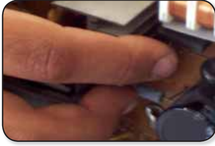
صورة لشخص في دائرة تماس كهربائي
